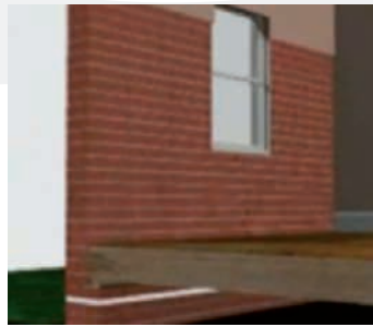
Pared con DRYZONE inyectado y revoco extraído
